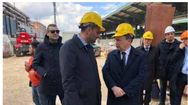
Sopralluogo del sindaco Decaro alla stazione di Bari Centrale su stato avanzamento lavori
